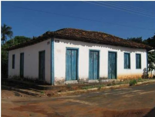
Foto 1: Vista da fachada lateral direita* e frontal. Março/2009 - Fotógrafa: Fernanda Caldeira de Lacerda
