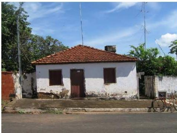
Foto 1: Vista da fachada frontal.
