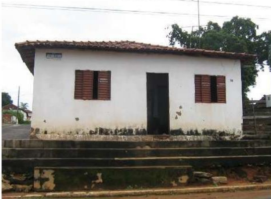
Foto 1: Vista da fachada frontal.
