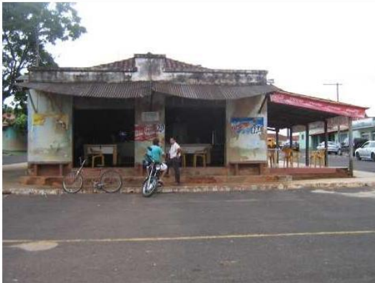
Foto 1: Vista da fachada frontal.
