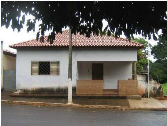
Foto 1: Vista da fachada frontal.
