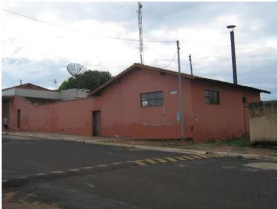
Foto 1: Vista da fachada frontal e lateral esquerda*. Março/2009 - Fotógrafa: Fernanda Caldeira de Lacerda
