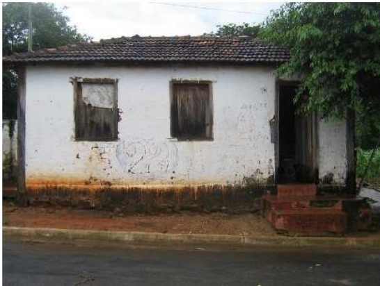
Foto 1: Vista da fachada frontal.
