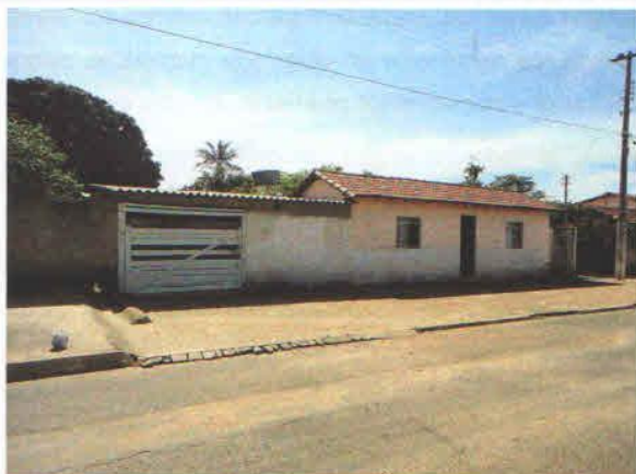
Foto 1: Residência de Misael José de Oliveira. Fachada frontal. Data: novembro/2010. Foto: Iara Camacho
