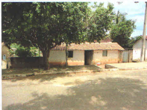
Foto 1: Fachada frontal. Data: nov/2010. Foto: Iara Camacho
