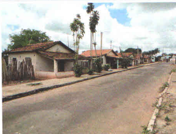
Foto 2: Conjunto habitacional construído em 1982. Vista geral, lado sul. Data: novembro/2010. Foto: Iara Camacho
