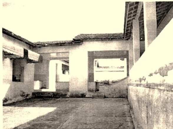
Foto 2: Vista do pátio interno da Escola Estadual Cel. Faleiro de Aguiar. Fev-2008. Foto: Talita Rodrigues Pereira
