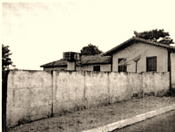
Foto 2: Vista lateral esquerda da residência. Fev/2008. Foto: Talita Rodrigues Pereira
