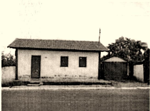
Foto 1: Vista frontal da residência. Fev/2008. Foto: Talita Rodrigues Pereira
