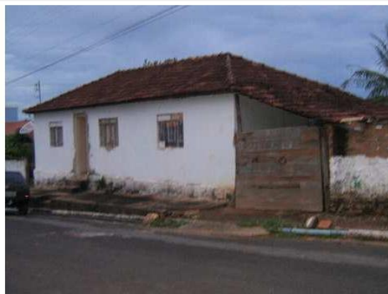
Foto 2: Vista da fachada frontal e lateral esquerda*. Março/2009 - Fotógrafa: Fernanda Caldeira de Lacerda
