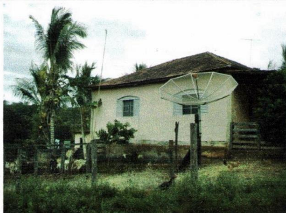
Foto 02: Vista fachada lateral esq. da Faz. Jorge Cândido Silva Data: 07/02/07 - Fotógrafa: Priscila Monteiro Mourão
