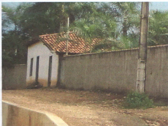
Foto 1: Casa de Máquina de Arroz. Fachada frontal. Data: novembro/2010. Foto: Iara Camacho
