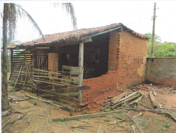
Foto 3: Casa da Máquina de arroz. Vista geral. Data: novembro/2010. Foto: Iara Camacho
